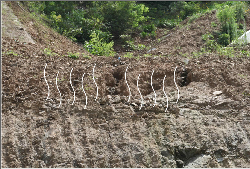
【그림 23】 B 영역 상세사진 (토사유실 및 우류침식)
