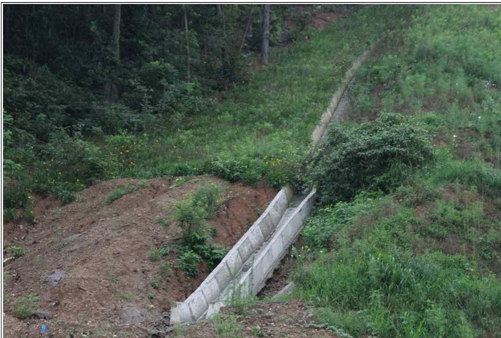
【그림 6】 산마루 배수구 설치구간
