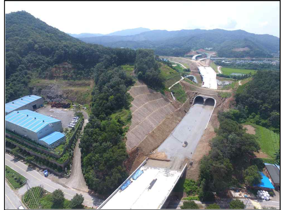
【그림 4】 깎기비탈면 종점부 측면 사진
