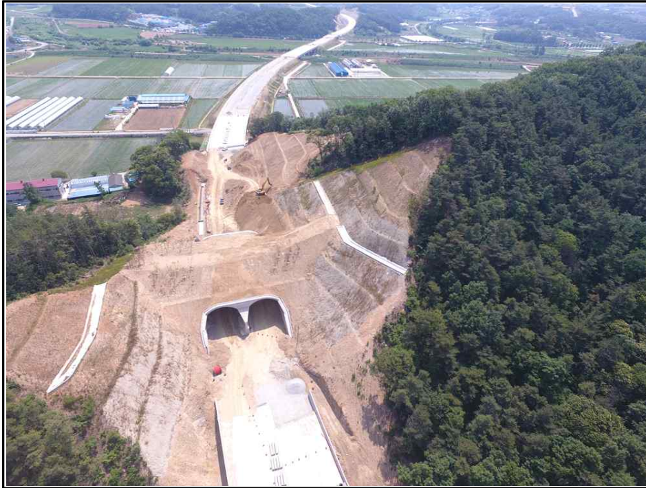
【그림 3】 깎기비탈면 시점부 측면 사진
