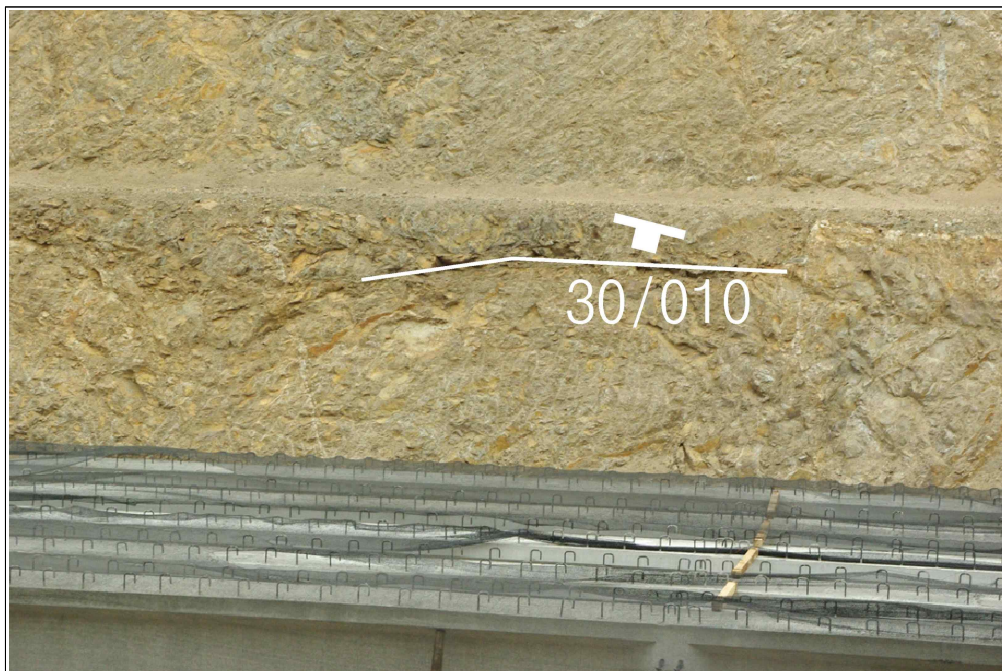
【그림 27】 C 영역에 발달한 불연속면
